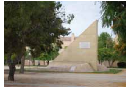
Vista panorámica del edificio y reloj de sol
